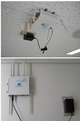
図 6 壁及び天井に設置された PCWL Fig. 6 PCWLs installed on the ceiling and wall.
